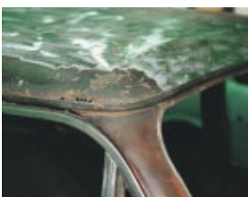
屋根部分にも腐食による穴があいている
