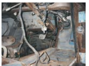
室内でも腐食部分が多い全ての部品を取り外す
