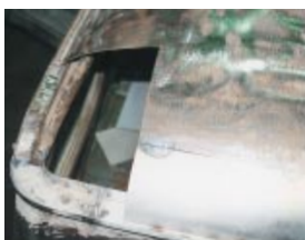
腐食部分を切断
