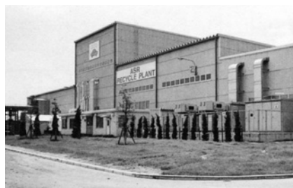
ASRリサイクルプラント(愛知県半田市)
