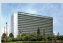
本社テクニカルセンター
