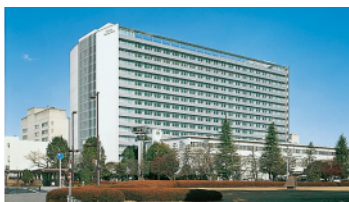
本社テクニカルセンター (愛知県 豊田市)
