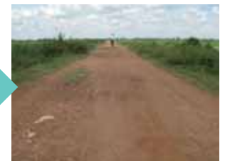
「土のう」で改修された道
