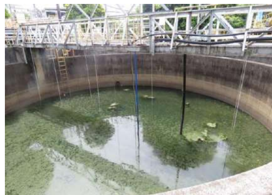
トンボに配慮した緊急槽 (ロープ設置と通年の水張り)
