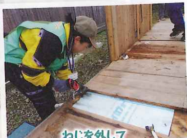
ねじを外して 床材をはがします
