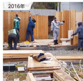
2016年 仮設住宅の解体(住田町)
