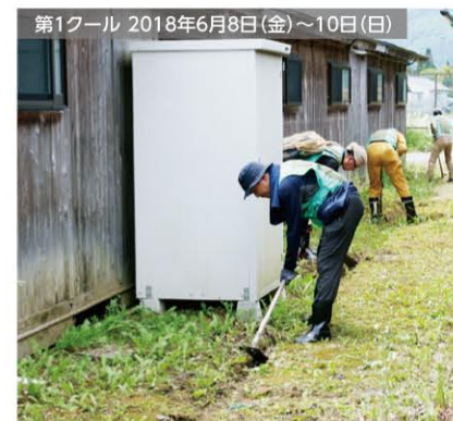
中上仮設住宅地での排水溝の整備
