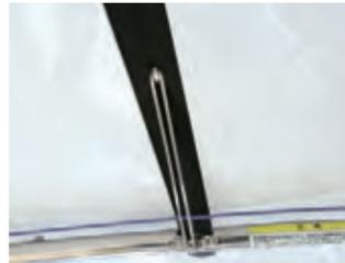
コンパクトに納められているモーターユニットや動作部が特許の部分。レール部分がレールの内部に収まっていて、出っ張りがない。
