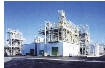
バイオプラスチック実証プラント
