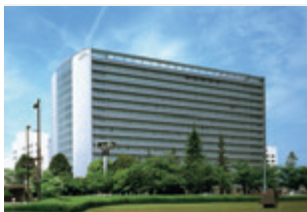
トヨタテクニカルセンター (愛知県豊田市)
