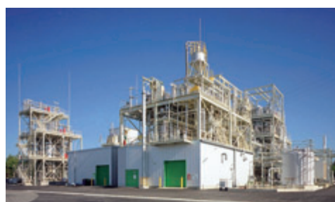
広瀬工場の実証プラント
