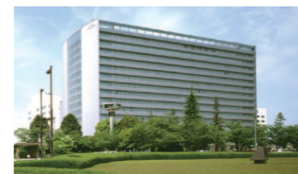
本社テクニカルセンター
