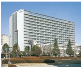
本社テクニカルセンター
