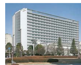
本社テクニカルセンター
